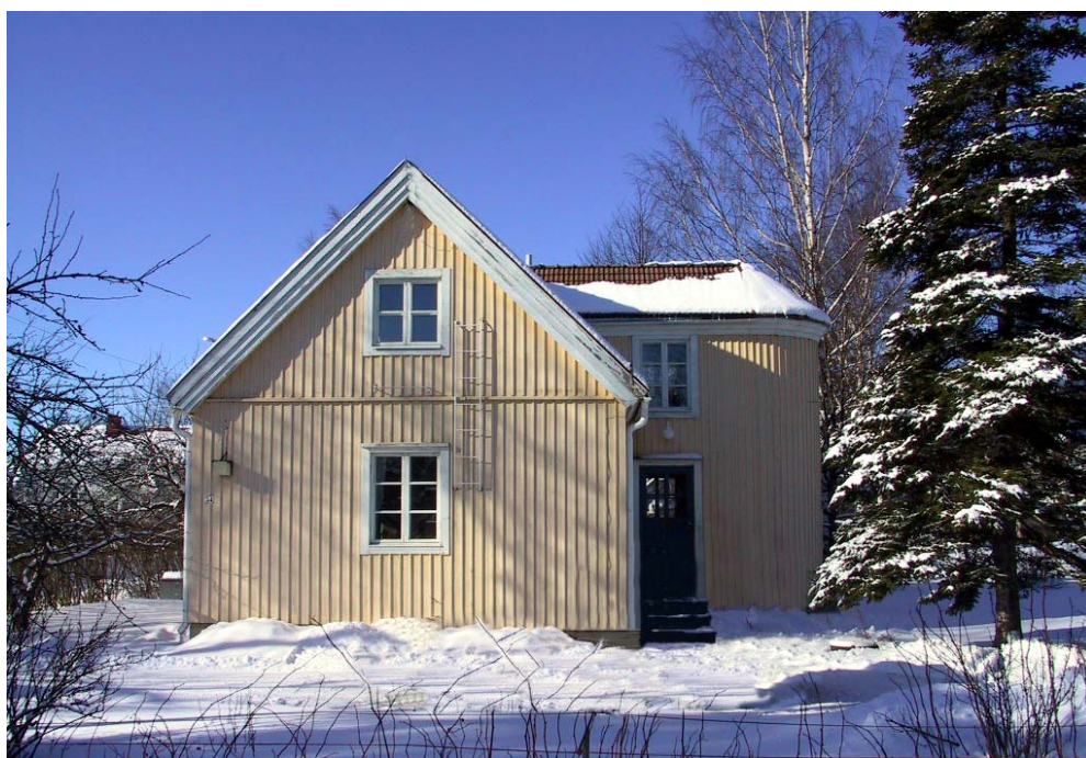
Porras on sijoitettu hirsirungon ulkopuolelle kauniisti toteutettuun laajennusosaan.
